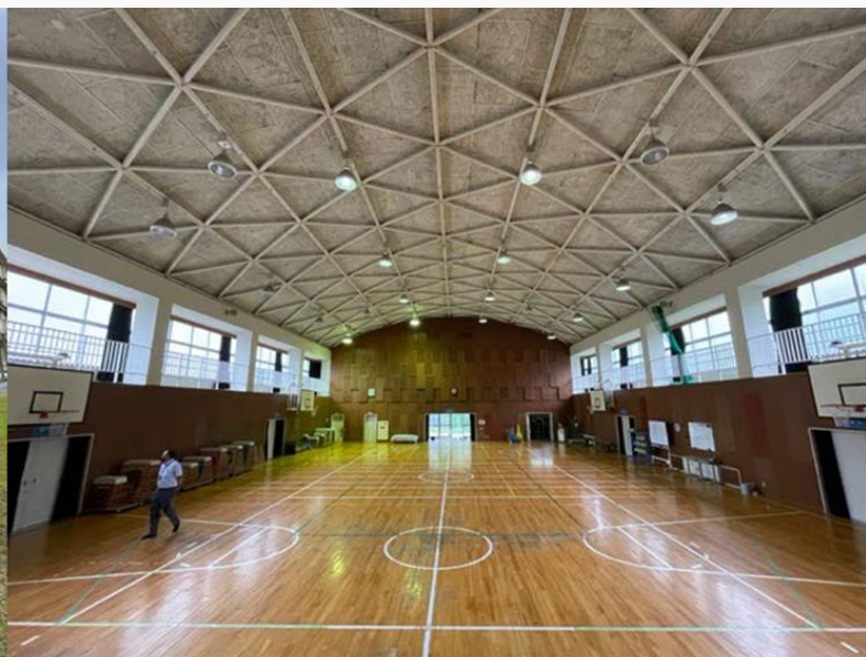
小学校 屋内運動場
