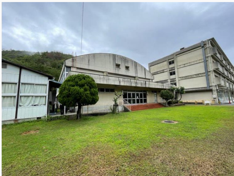
小学校 屋内運動場 校舎
