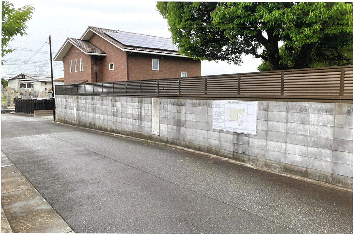
遠 景 （北側道路）
