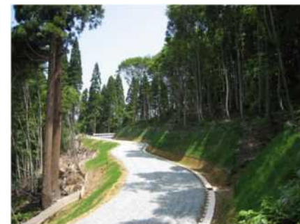
林道設計における現地形に沿った波型線形の採用 (在来種の生息・移動空間の確保)
