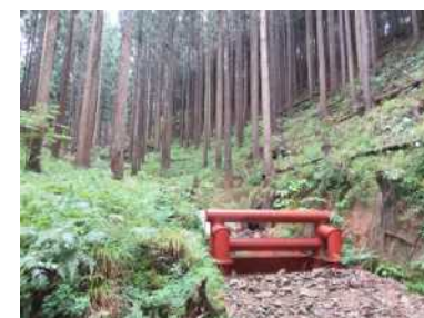
溪畔林の間伐と簡易流木止め施設（穴栗市）
