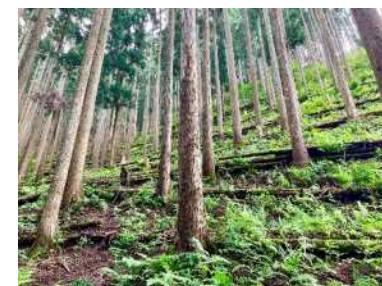
伐採木を使用した土留工（養父市）
