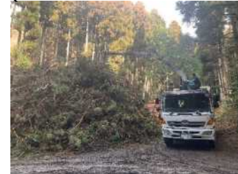
枝葉等の林地残材のストック・搬出 (穴粟市内バイオマスヤード)
