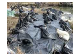
遮光シートの設置
