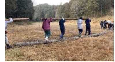
湿原内の木道の修繕
