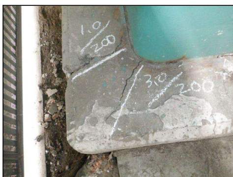
下部工にひびわれが見られます
