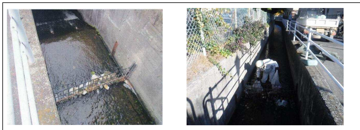
図 3-1-6 水路のスクリーン巡視・清掃作業の状況
