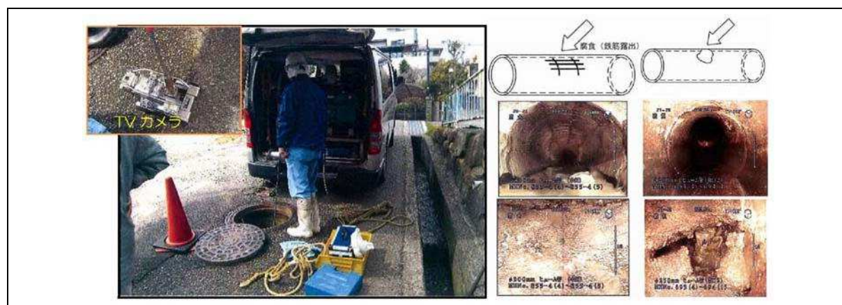
図 3-2-2 TV カメラ調査状況（左）、管内の劣化状況（右）
