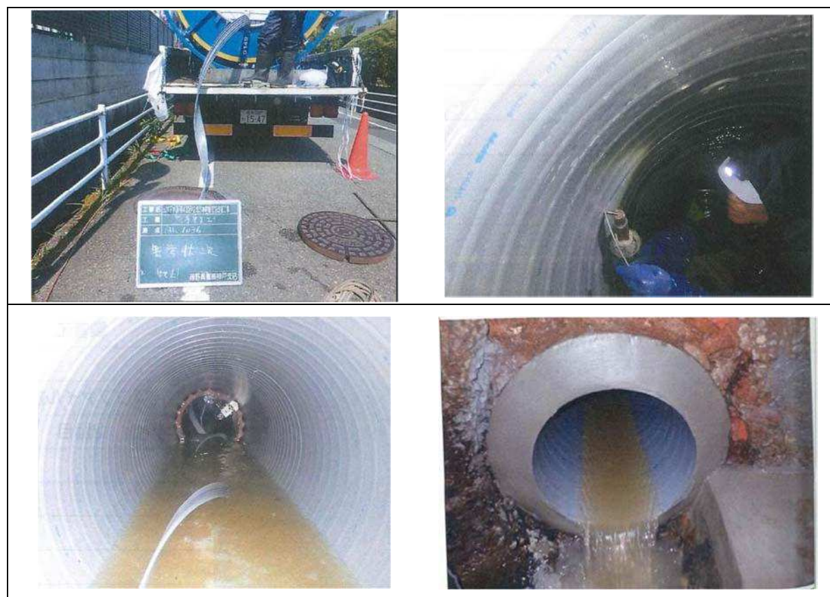
図 3-2-7 管渠改築状況（巻き出しリングによる製管）
