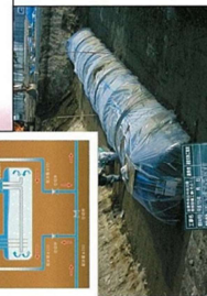
■ 耐震性貯水槽（100m 3 ） 災害時、避難者の飲料水を確保すると共に、近隣火災時には防火用水としても利用できます。
