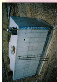
■ 井水取水槽（56m 3 ） 既設深井戸からの井戸水と雨水を一時的に貯水すると共に、消防用防火槽としても利用します。
