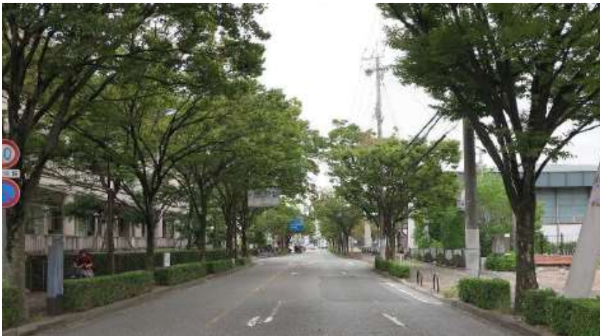
⑤逆瀬川米谷線（市役所前区間）
