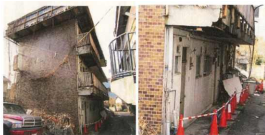
外壁・手すりが崩落した事例
