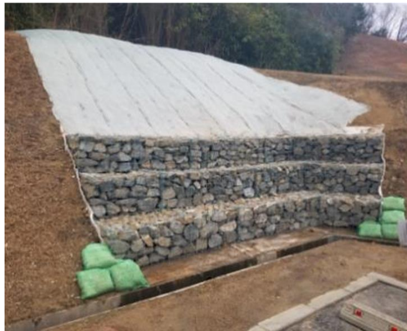
令和6年3月 高さ30cmのふとんかごを3段設置。 山裾部分に道路側溝へ雨水を 誘導する溝を作り復旧。
