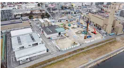
新ごみ処理施設工事全景（令和7年1月時点）
